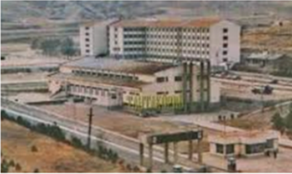
Okulun mimarî yapılanması
